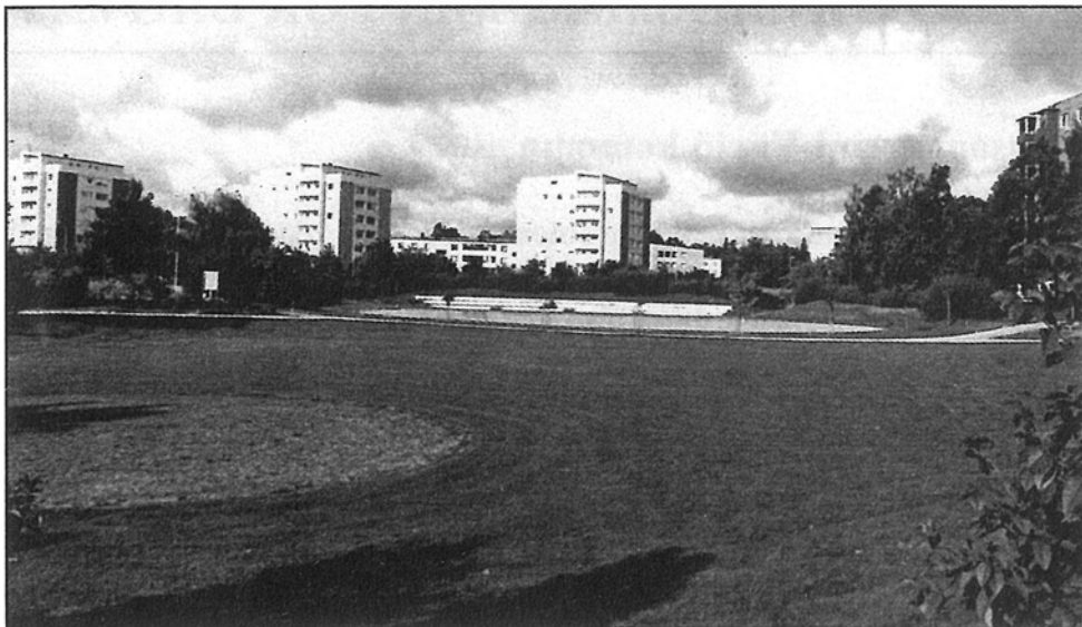
Figur 8 Spetsamossen - dagvattenmagasin och parkområde
