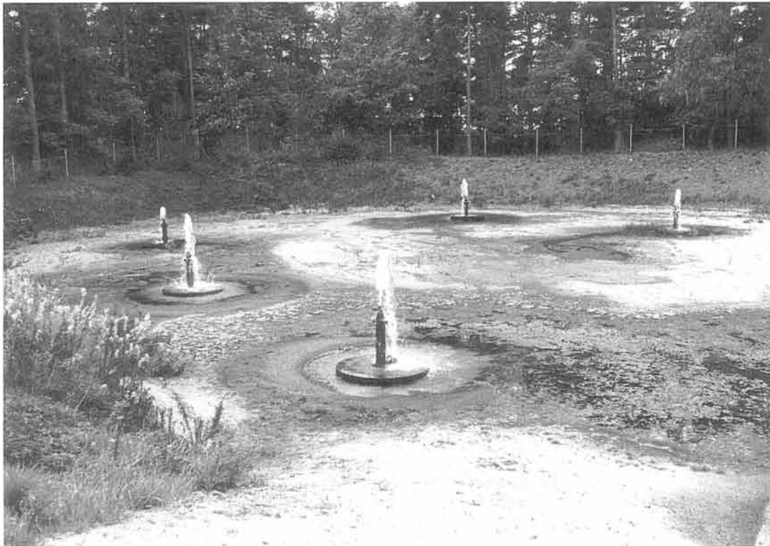
Figur 3.3. En infiltrationsdamm på Galgbackens vattenverk i Hässleholm. För att få en uppfattning om vattenlösta algtoxiner bryts ner i långsamfilter utförde finska forskare perkolationsstudier med 24 cm höga sandfilter. Trots att de uppmätte en viss reduktion ansåg de att man behövde studera algtoxiners nedbrytning genom långsamfilter i drift innan man kunde dra slutgiltiga slutsatser om biologiska filters effektivitet i det här avseendet. Foto: Kim Johansen.
