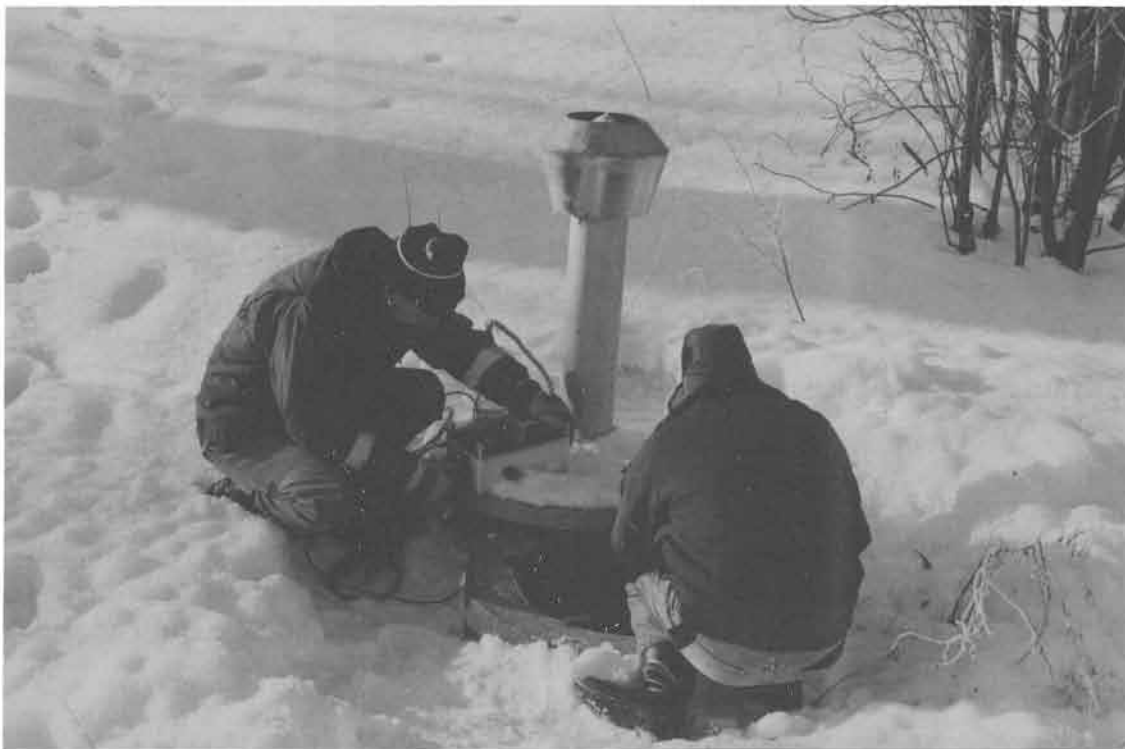
Fig 32. Installation av mätutrustning i brunn försedd med specialtillverkad luftningshuv
