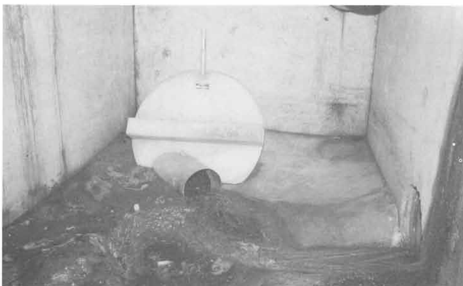
Exempel på flödesregulator, typ cyklonbroms.
