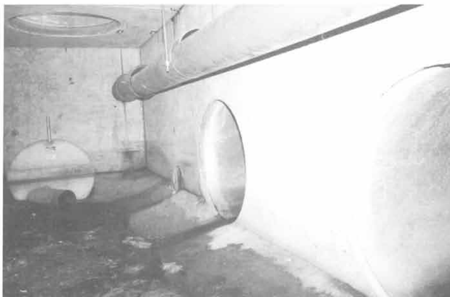
Helsingborg, Växjöгатan, rörpaket
