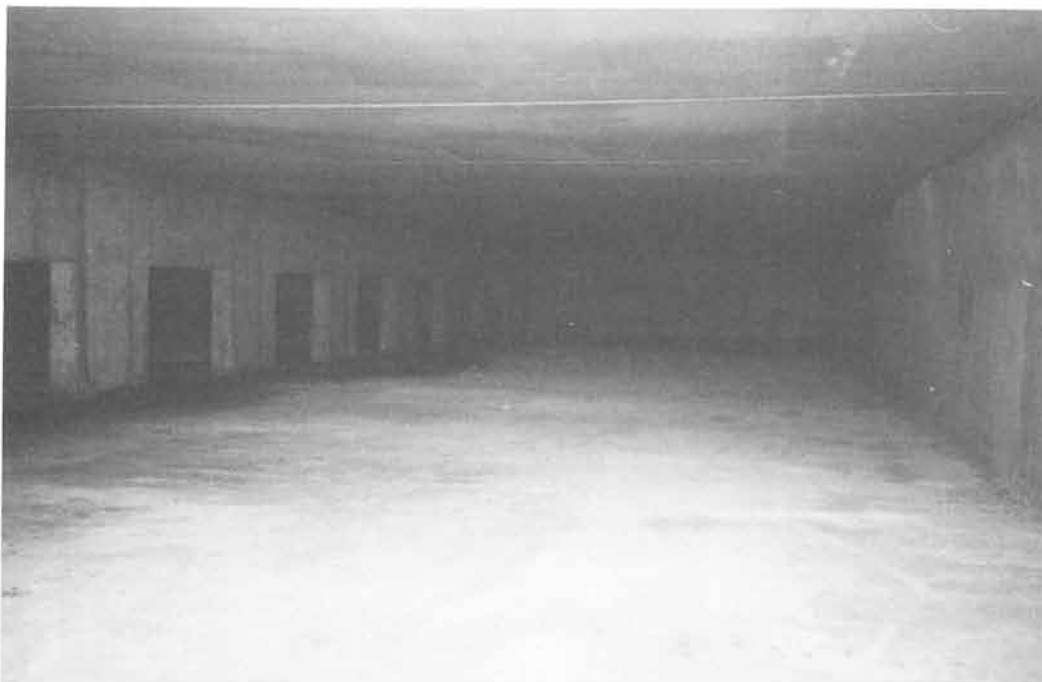
Exempel på sidomagasin med plan botten.
