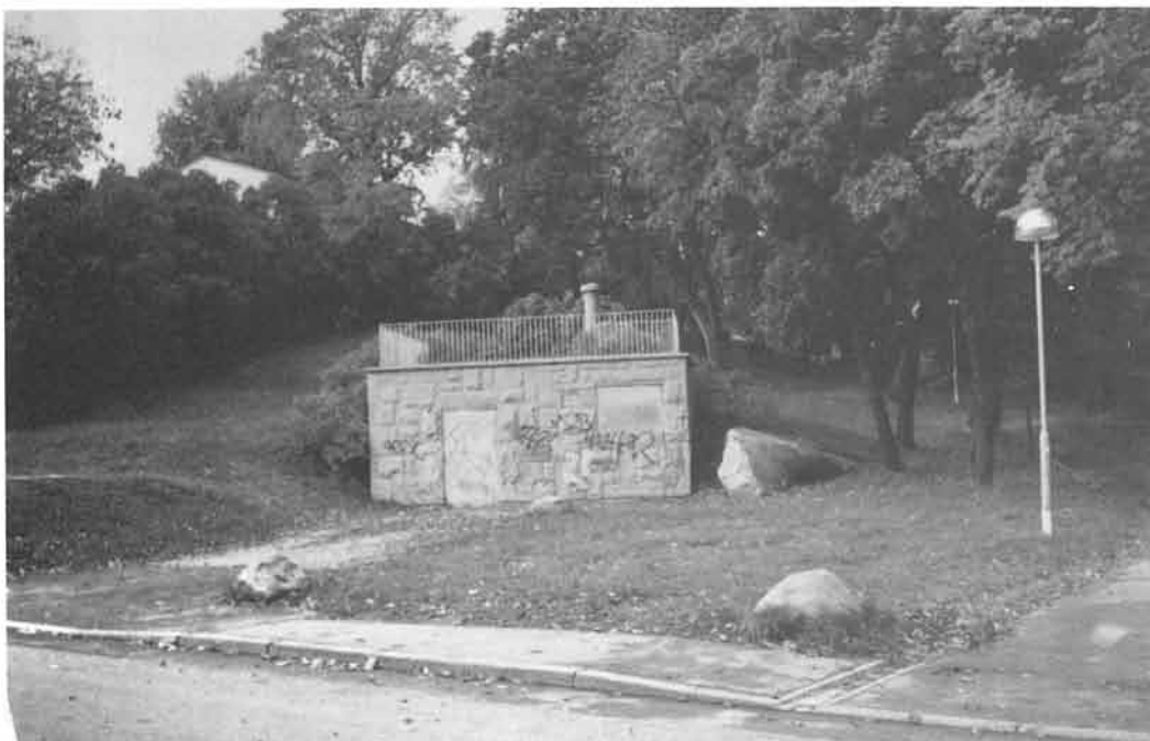
Ingång tunnel - pumpstation
