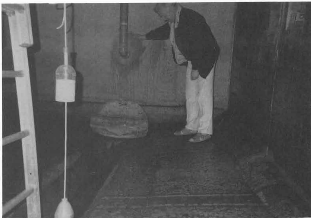
Regulator och i förgrunden maxnivåmätare (Bertil S)
