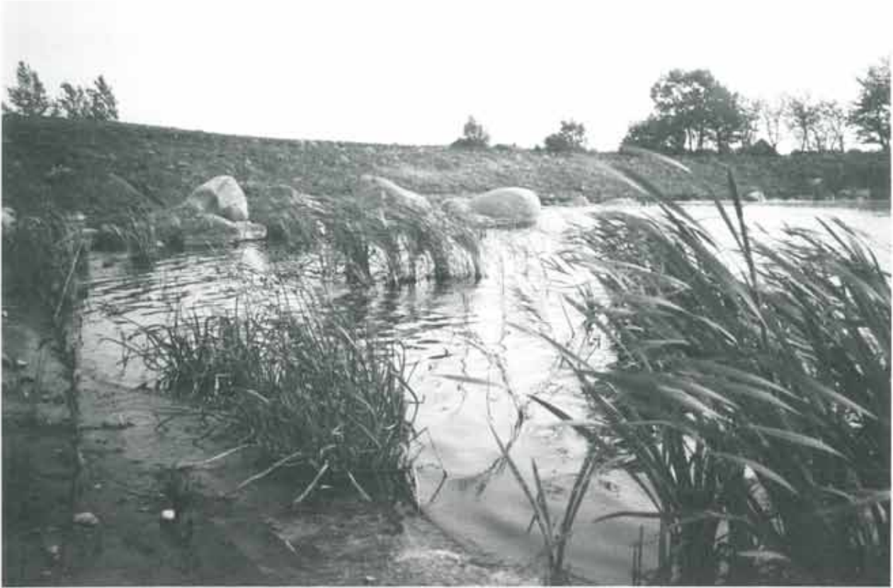
Utjämningsmagasin/damm för dagvatten i Löderup. Foto: Siv Bengtsson-Lindsjö
