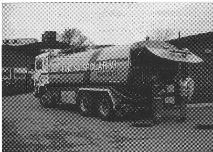
Figur 2. Rotskärning och högtrycksspolning är de vanligaste metoderna som används för att avlägsna rötter i ledningarna. Överst rotskäringmunstycke, underst spolbil. (Foto: Ulla-Britt Thorén)
