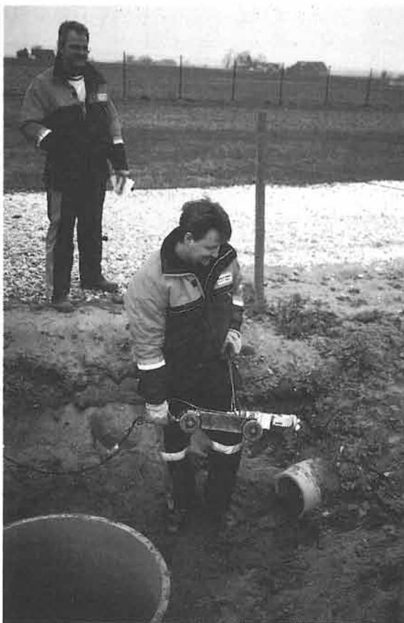
Figur 10. TV-inspektion inne i avloppsledningen bör alltid företas innan beslut tas för en definitiv åtgärd mot rotinträngningsproblemet på aktuell ledningssträcka. (Foto: Örjan Stål)
