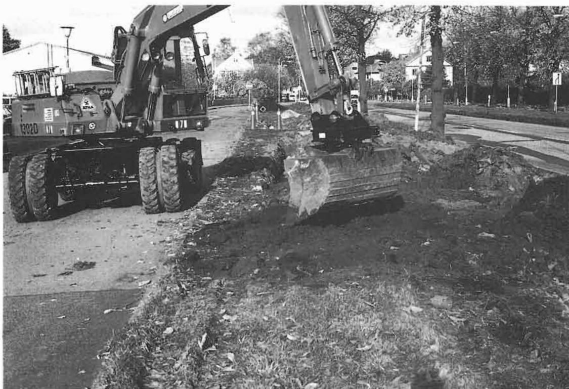
Figur 17. Enklaste och bästa sättet att luckra kompakterad mark görs med grävmaskin. (Foto: Kaj Rolf)
