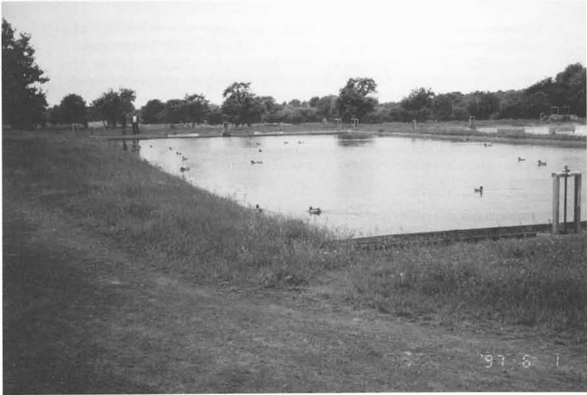
Figur 2.6 Damm för infiltration av renvatten för fukthållning.
