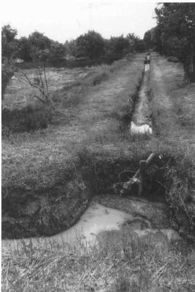
Figur 2.2 Kanalsystem för fördelning till olika infiltrationsbassänger.
