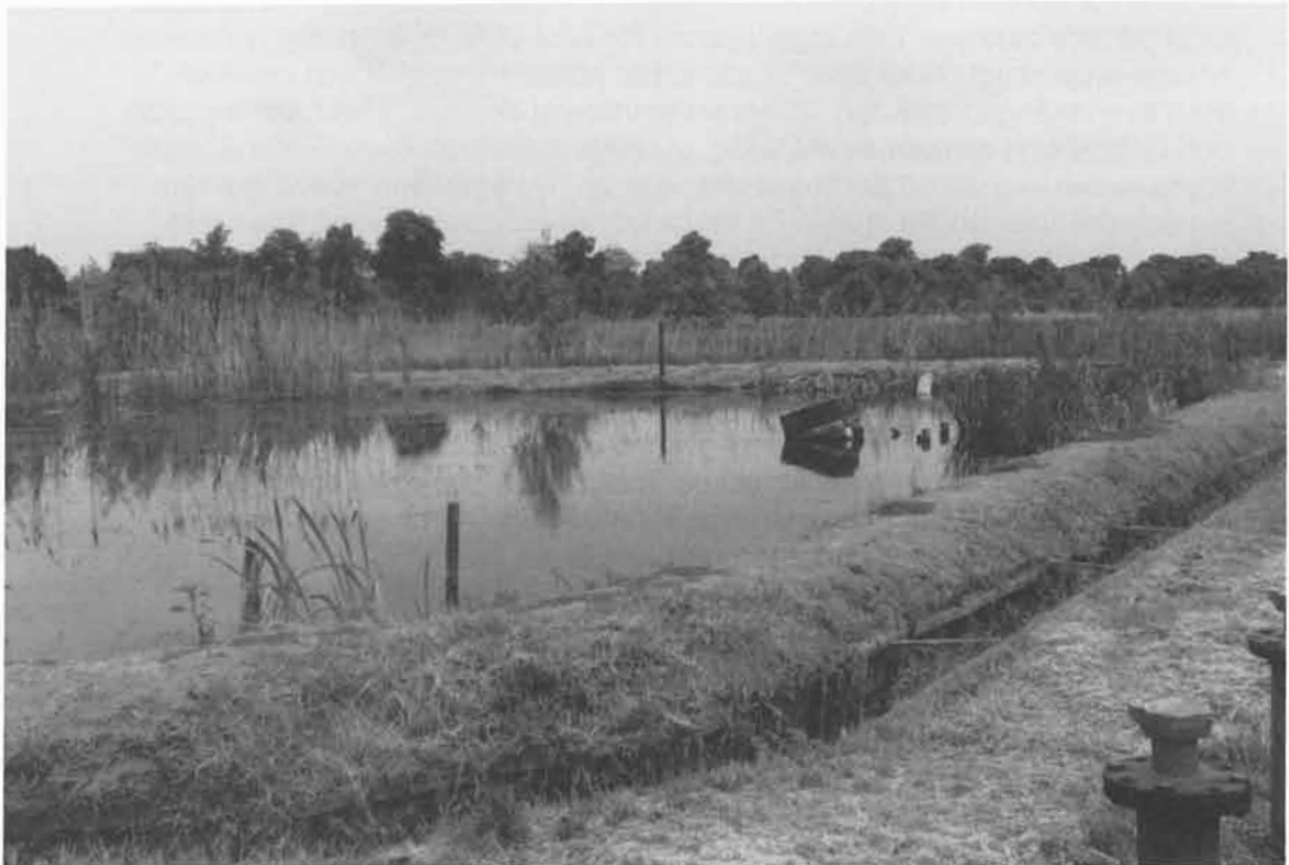
Figur 2.7 Våtmark med behandlat avloppsvatten för fukthållning.
