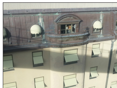
Figur 3.5 Fordons bromsbelägg och koppartak/-fasader är två av de största källorna till koppar i dagvatten.
