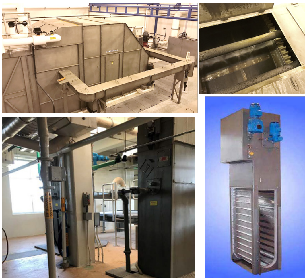
Figur 4.1 Finsil på Yellow River WRF (överst) och Broad Run (nederst).
