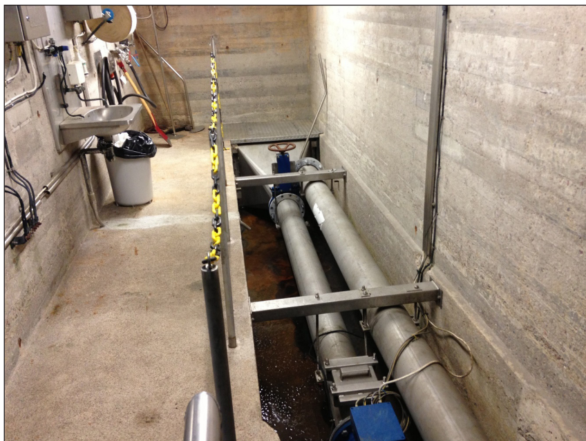
Figur 5-14 Flödesmätning med delvis fylld mätare (Käppalaförbundet, 2019)
