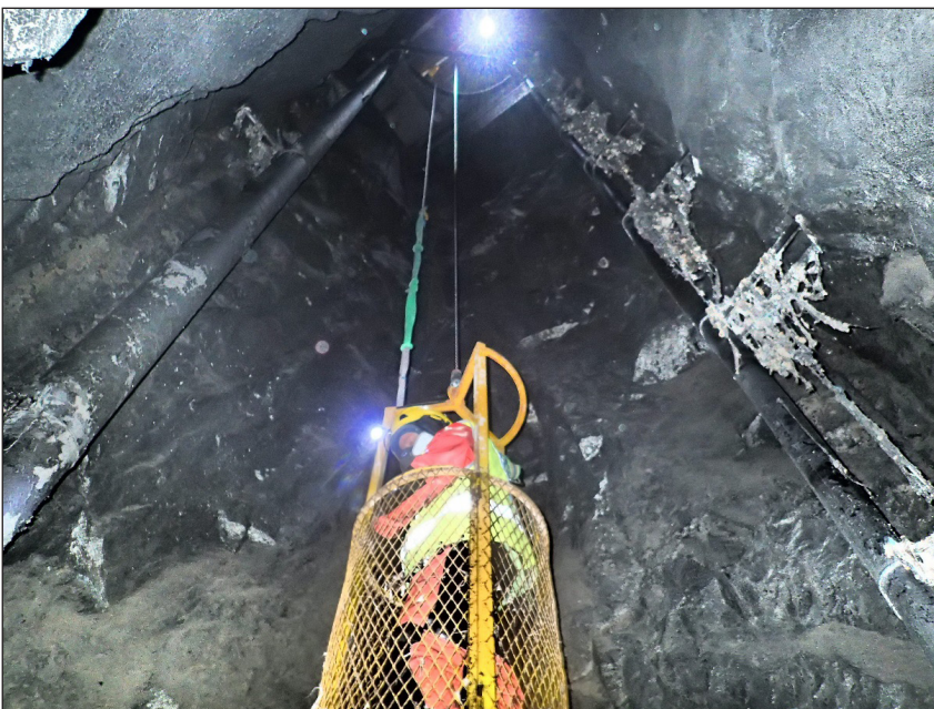
Figur 4-12 Exempel på ett räddningsschakt.
