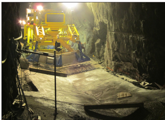
Figur 5-8 T.v. visar en nybyggd tunnel där en v-formad botten i betong tillverkas. T.h. tunnel med v-formad betongbotten (Käppalaförbundet, 2019)
