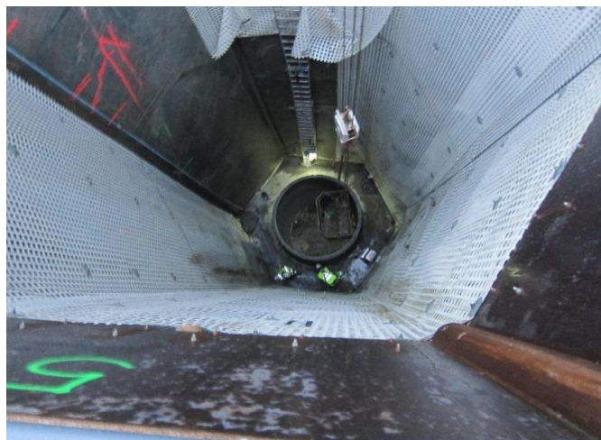
Schakt på 20m, byggnation av fundament
