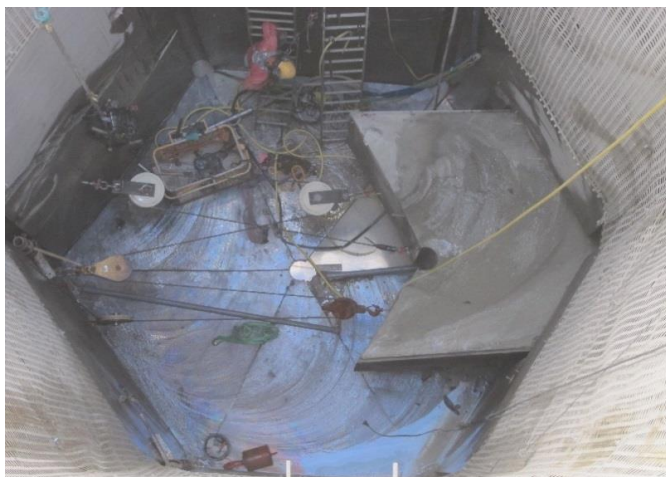
Stenblock från förbindelstunnel på väg ut.
