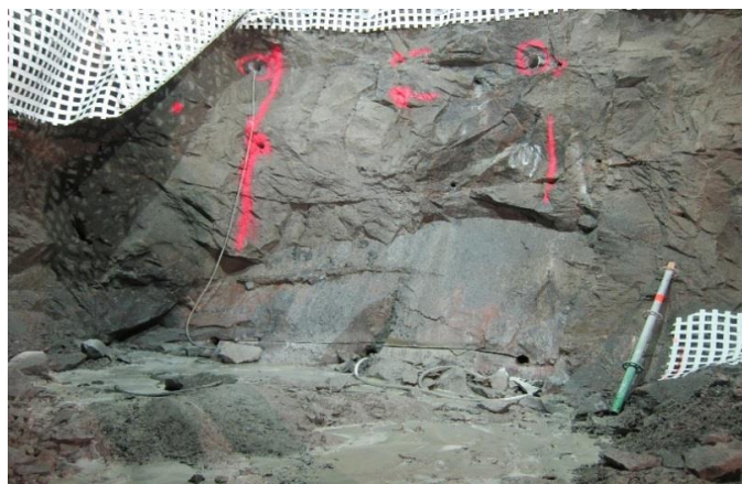
Wiresågning för förbindelstunnel förbereds
