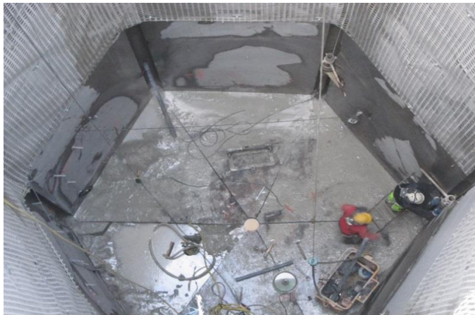
Wiresågning ner en bit i berget
