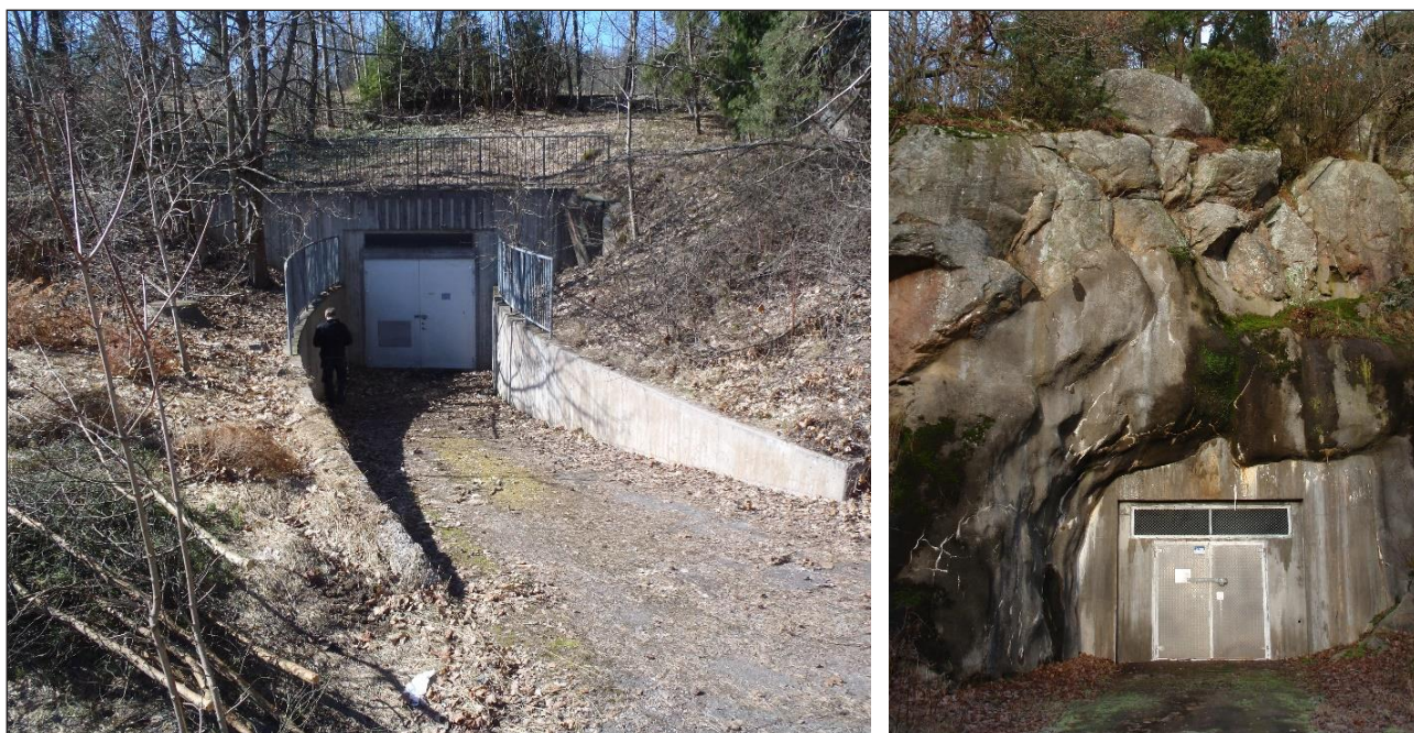
Figur 4-17 Exempel på tunnelpåslag från Käppalaförbundets system t.v. och Gryaabs t.h. (Käppalaförbundet, 2019) (Gryaab, 2019).
