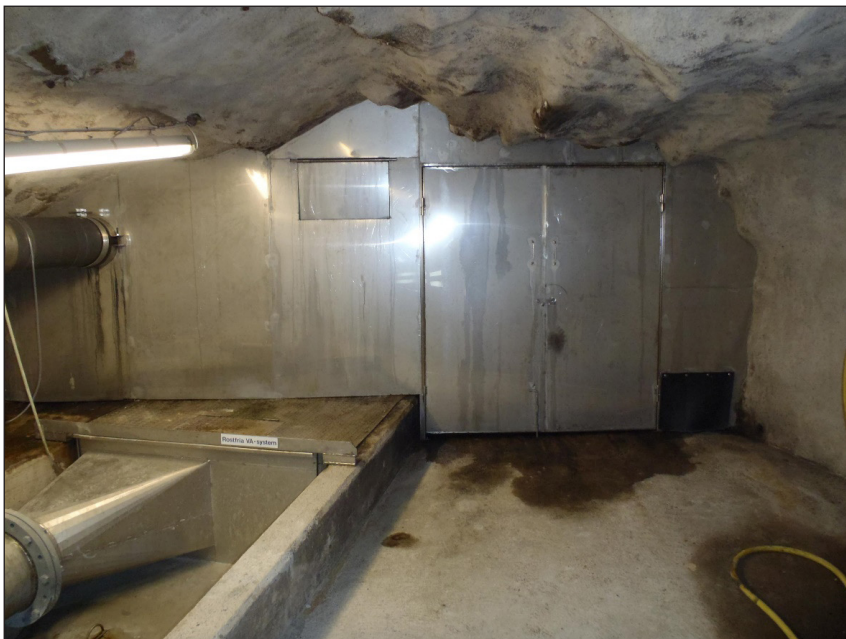
Figur 4-18 Tunnelpåslag med anslutning till vänster i bild (Käppalaförbundet, 2019).
