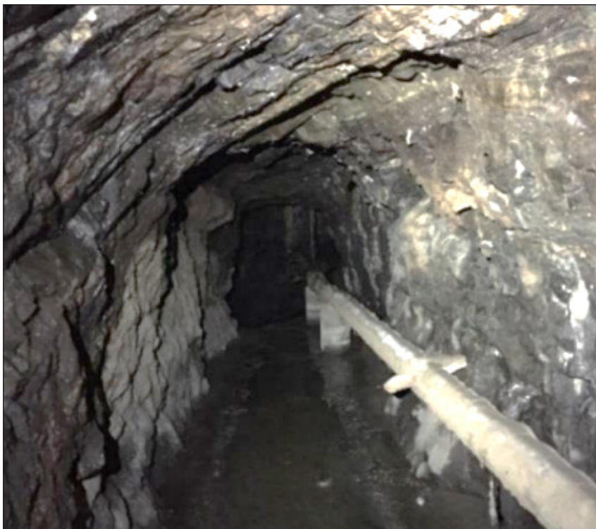
Figur 2-3 Sprängd tunnel som byggdes på 60-70-talet (Holmberg & Sjö Dahl, 2015).
