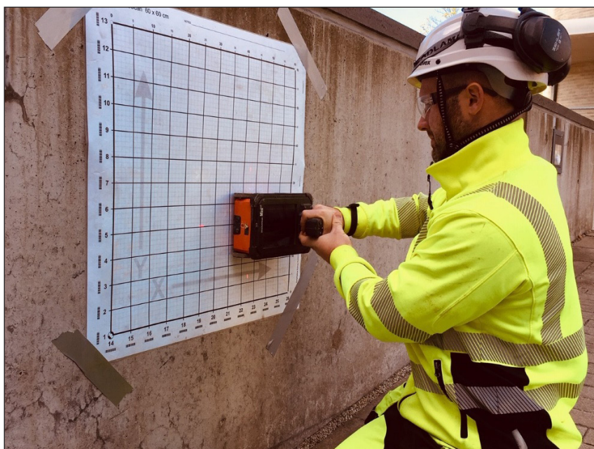
Figur 5.3 Mätning med georadar (ground penetrating radar, GPR) där mätningar görs längs med linjer på en upptejpad mall.
