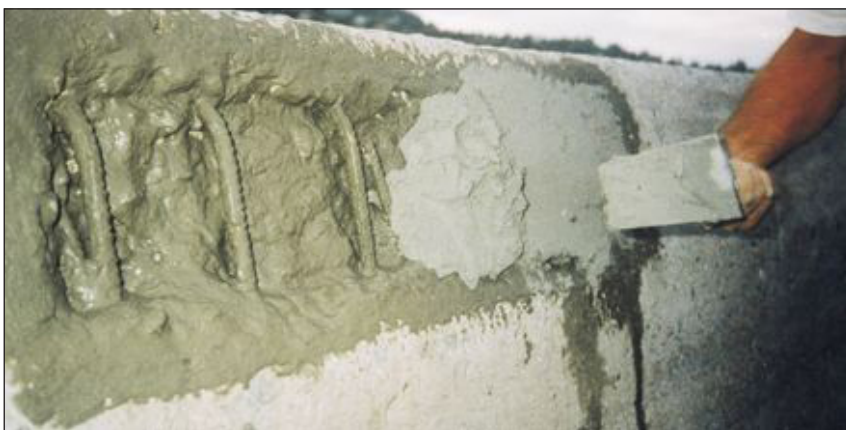
Figur 4.4 Reparationsbetong används vid betonglagningar och gjutningsarbeten.
