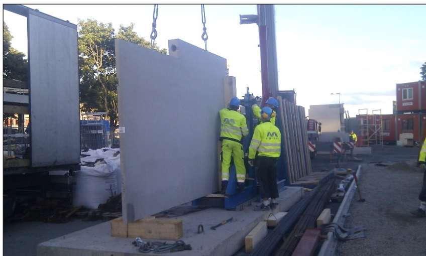
Figur 4.13 Prefabricerade betongelement som lyfts på plats med hjälp av lyftkran.
