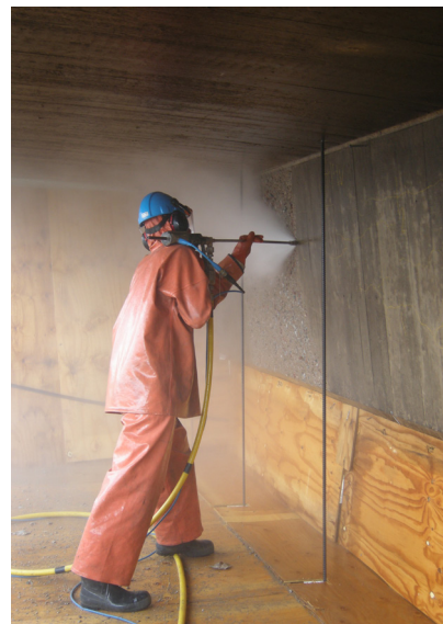
Figur 9.3 Vattenbilning som utförs för hand.
