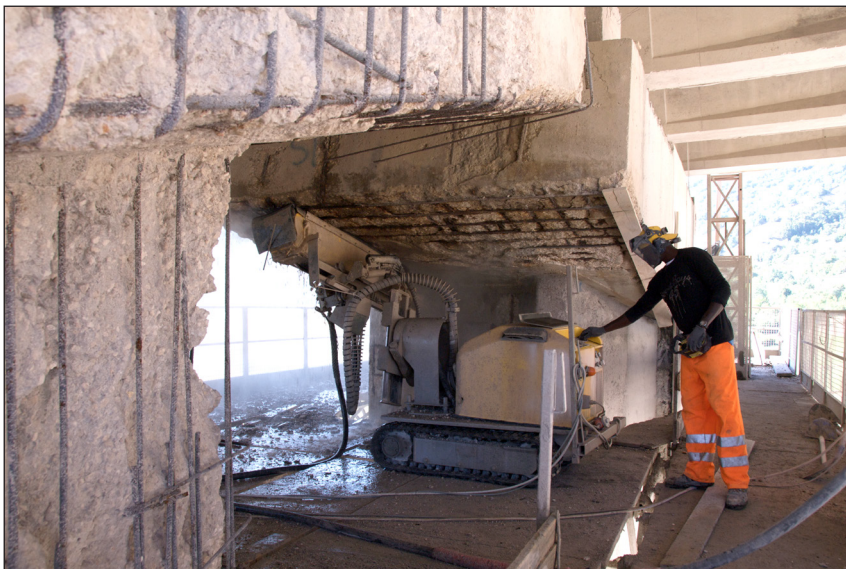
Figur 9.2 Vattenbilning med robot.
