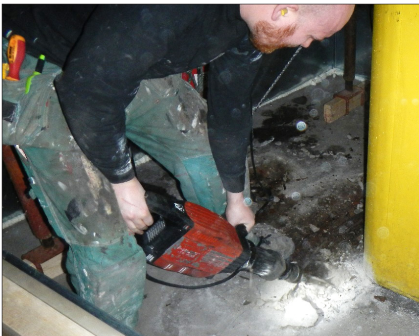
Figur 9.4 Mekanisk bilning kan användas vid rivning.
