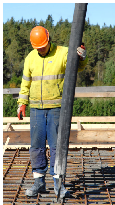
Figur 4.6 Självkompakterande betong behöver inte vibreras utan packar sig själv.
