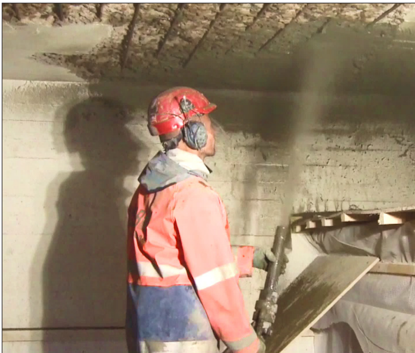
Figur 4.5 Sprutbetong är betong som appliceras genom sprutning och används vid exempelvis vid reparation av betongkonstruktioner. Foto: BESAB.
