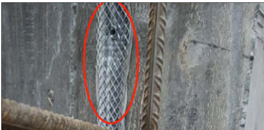
Figur 9.7 Svällband monterat på nygjuten och genomgående betongskarv. Här fäst med montagenät och expanderspik.
