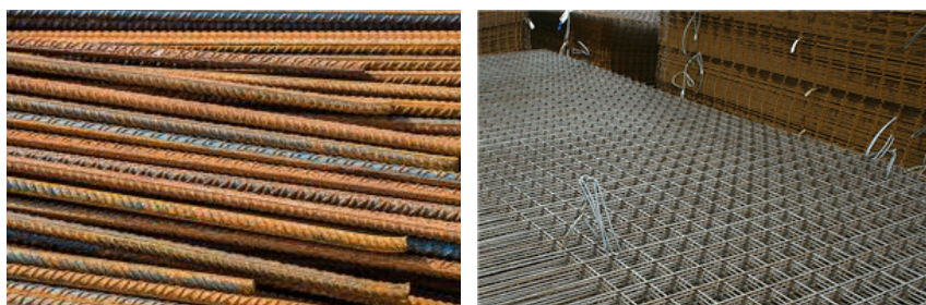
Figur 7.1 Till vänster syns armeringsstänger, till höger armeringsnät.
