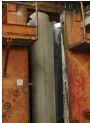
Figur 4.10 Kvarvarande form 24 timmar efter gjutning och sedan avformning, Berding beton
