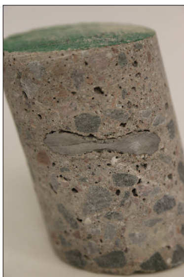
Figur 6.1 Utborrade provkropp med dålig vidhäftning samt mindre håligheter.
