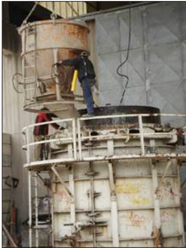
Figur 4.6 Gjutning med färsk betong, Berding Beton
