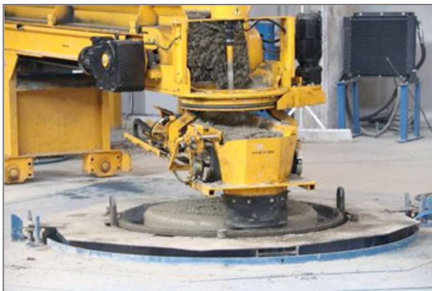
Figur 3.5 Påfyllning av jordfuktig betong i form, S:t Eriks
