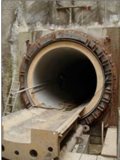
Figur 3.17 Öppning där man trycker in rören
