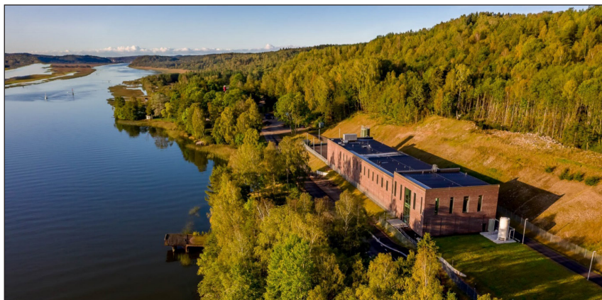
Figur 3.8 Kungälvs nya vattenverk (foto tillhör Kungälvs kommun).
