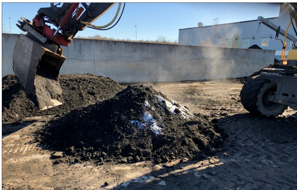
Figur 3.3 Inblandning av urea med grävmaskin i avvattnat slam.
