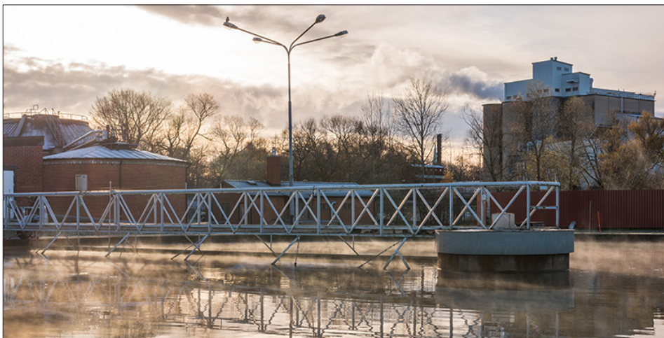
Figur 1.4 Sedimentationsbassäng vid Nykvarnsverket.
