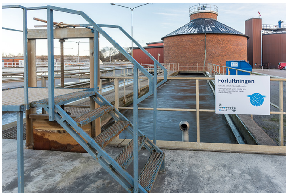
Figur 1.3 Förluftningen vid Nykvarnsverket.
