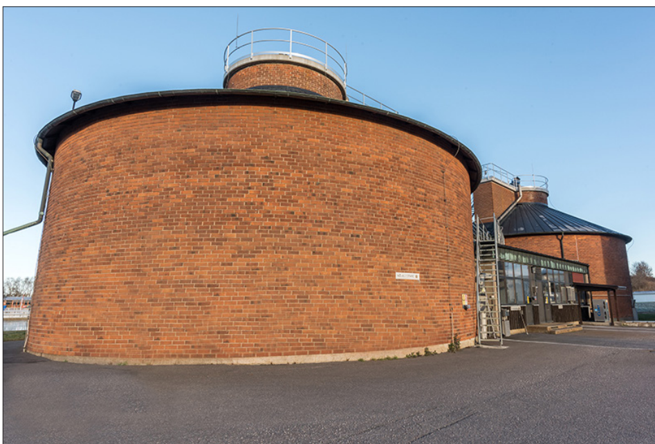
Figur 1.5 Två av Nykvarnsverkets rötkammare, den tredje rötkammaren ligger strax till höger om bilden.
