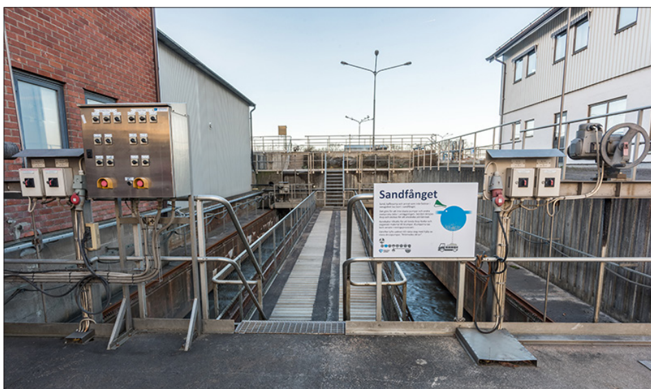
Figur 1.2 Sandfånget vid Nykvarnsverket.
