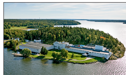
Figur 1.1 Flygbild på Görvälnverket som ligger i Järfälla kommun norr om Stockholm
