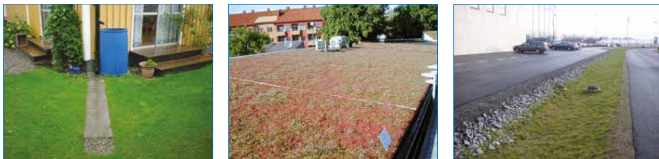
Figur 1.20 Exempel på åtgärder för att fördröja dagvatten.
