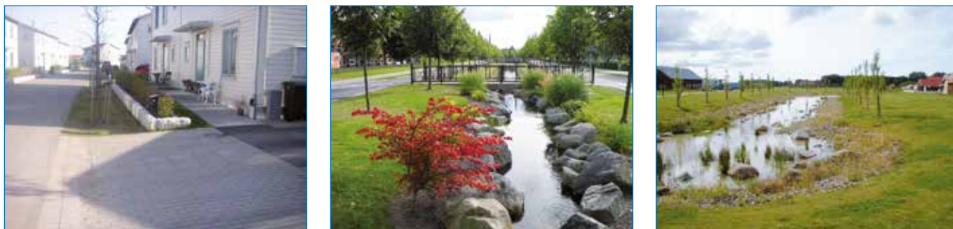
Figur 1.21 Exempel på åtgärder för hållbar hantering av dagvatten. Bild från vänster: Säker höjdsättning fastighet – gata. Bild i mitten: Öppen avledning istället för tidigare kulverterad avledning. Bild till höger: Öppet avvattningsstråk.
