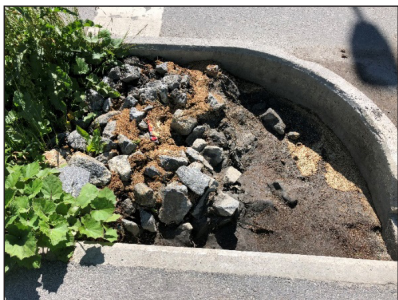
Figur 9.6 Försedimentering av biofilter: Mindre försedimentering; Översilningsyta för försedimentering och försedimenteringsdamm för större biofilter.
