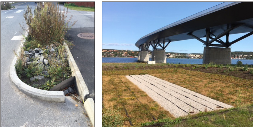
Figur 9.2 Biofilter i olika storlekar
