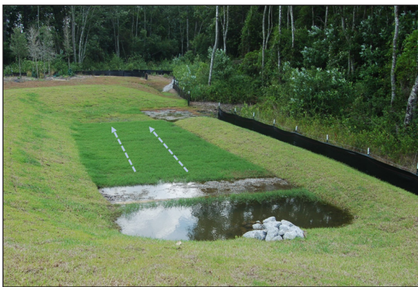
Figur 8.2 Översilningsyta. Foto: Ryan Winston.
