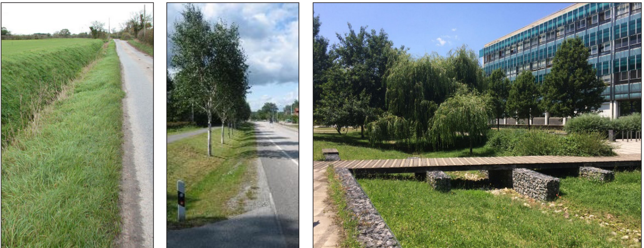
Figur 7.2 Väg- och svackdiken med olika släntlutningar
