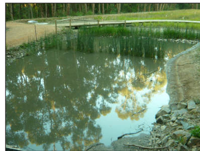
Figur 9.6 Försedimentering av biofilter: Mindre försedimentering; Översilningsyta för försedimentering och försedimenteringsdamm för större biofilter.
