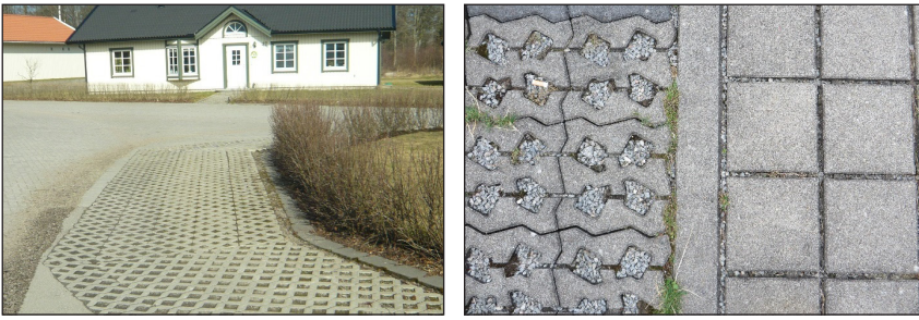
Figur 10.2 Olika permeabla beläggningar med hålsten/betongraster och plattor anlagda med avstånd för möjlighet till infiltration
