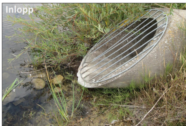
Figur 12.3 Inlopp till en dagvattendamm
