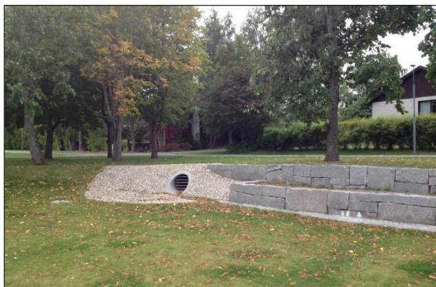
Figur 6.2 Torra dammar med inlopp och ränna (höger)
