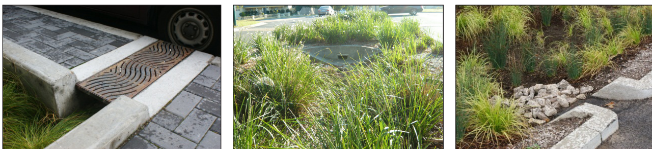
Figur 9.5 Exempel på olika typer av koncentrerad inloppslösning
