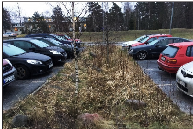
Figur 7.4 Plantering med svacka vid parkering. Svackdike med högre vegetation som kan bidra till förbättrad rening vid parkering
