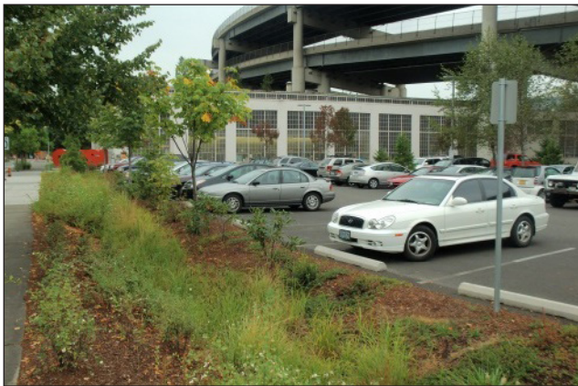
Figur 7.4 Plantering med svacka vid parkering. Svackdike med högre vegetation som kan bidra till förbättrad rening vid parkering
