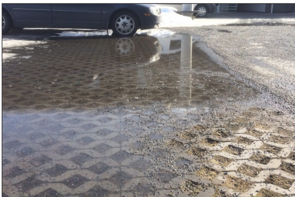
Figur 10.4 Igensatt f.d. permeabel yta
