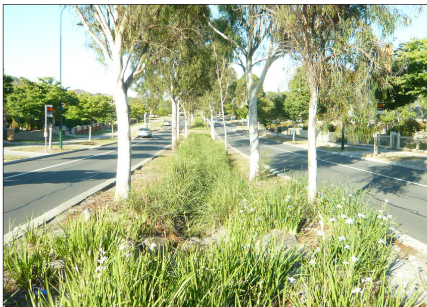
Figur 9.3 Biofilter i dike med dräneringsrör. Vid intensiva regn avleds vattnet längs svackdiket
