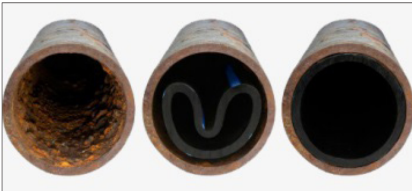
Figur 2.3 T.v. gammal ledning, i mitten gammal "fräst ledning" med u-liner, t.h. ny PE-ledning i gammalt gjutjärnsrör. Bild: Med tillstånd att publicera från SVATEK.
