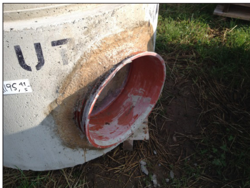
Figur 3.2 Fogning med injuten rörbit från brunnstillverkaren. Foto: Helena Mårtensson
