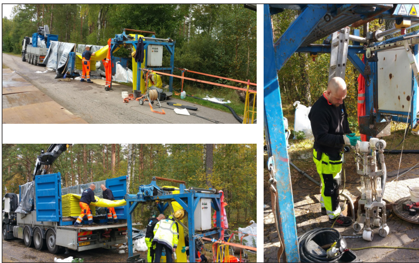
Figur 2.6 Relining med flexibelt foder av glasfiberarmerad polyester. Härdning med UV-ljus.
