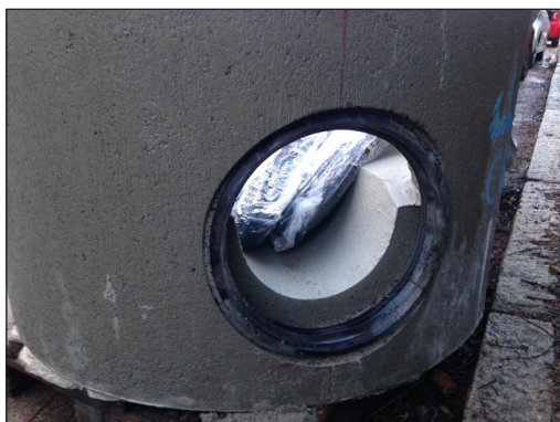
Figur 3.3 Fogning med Ibeco 910 packning som först måste anslutas till ett slätt rör och därefter till det ribbade röret med en övergång. Foto: Helena Mårtensson.
