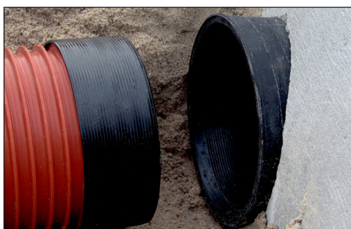
Figur 3.4 Fogning med Multi-seal packning mellan betongbrunn och ett ribbat rör av PP. Foto: Kombiringen AB, med tillstånd att publicera.
