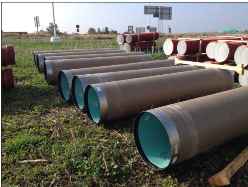
Figur 2.5 Exempel på glasfiber armerade självfallsledningar i dimension 600 mm. Foto: Mårtensson.
