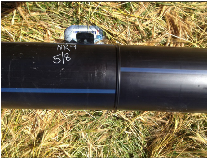
Figur 2.10 Exempel på stumsvets vid fogning av två PE100-rör dim. 315 mm. Foto: Mårtensson.
