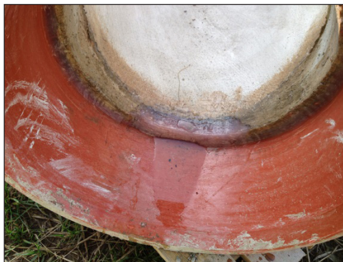
Figur 3.2 Fogning med injuten rörbit från brunnstillverkaren. Foto: Helena Mårtensson
